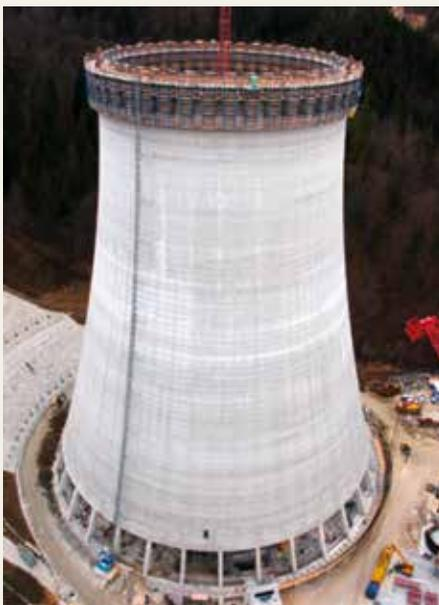
Der Neubau des 164,5 m hohen Kühlturms ist ein Hauptbestandteil der neuen Infrastruktur im Braunkohlekraftwerk Šoštanj. Pro Tag wuchs der Turm um 1,5 Meter.
