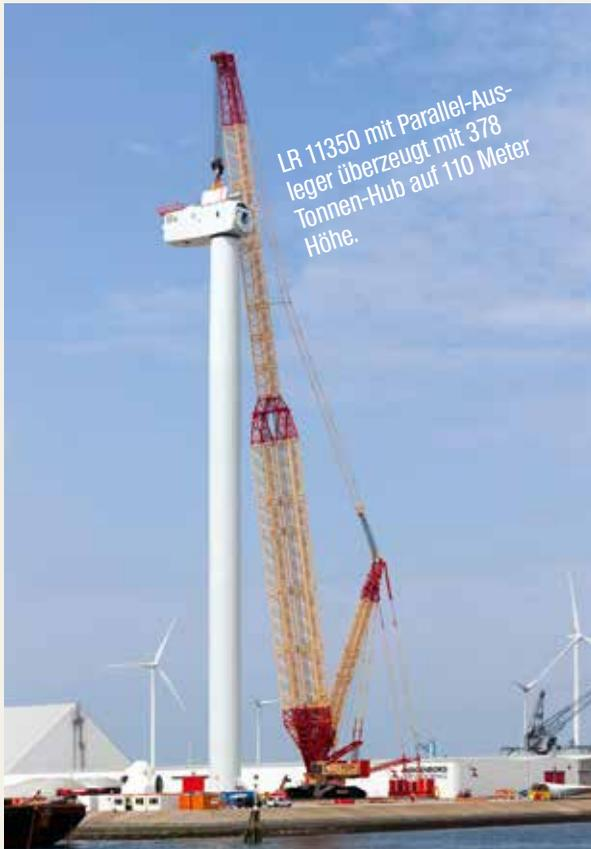
LR 11350 mit Parallel-Ausleger überzeugt mit 378 Tonnen-Hub auf 110 Meter Höhe.
