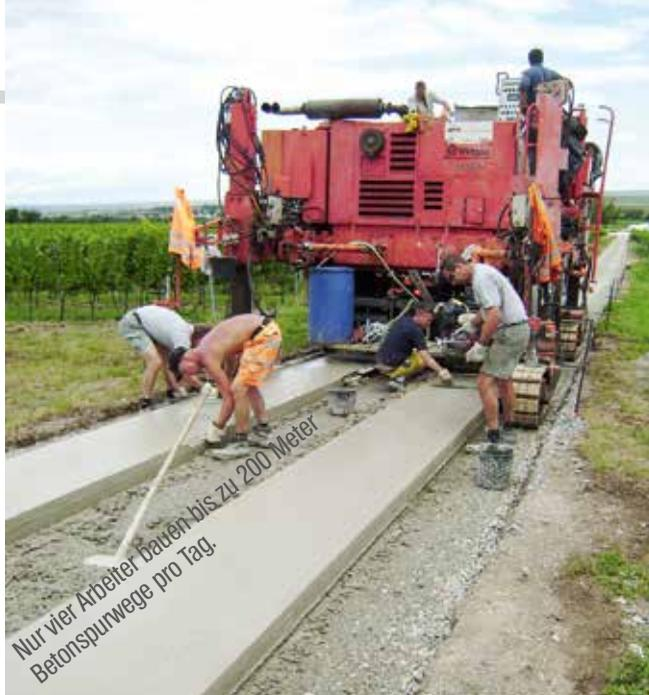
Nur vier Arbeiter bauen bis zu 200 Meter Betonspurwege pro Tag.
