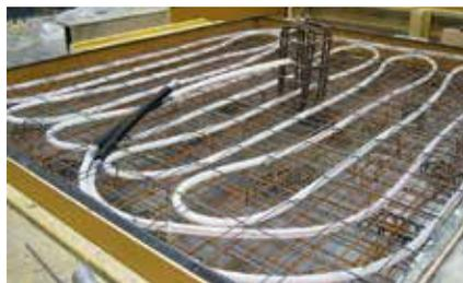
Durch die Variante der werksseitigen Integration der Heiz- und Kühlsysteme in die Betonfertigteile sind eine präzise Herstellung sowie eine schnelle und größtenteils witterungsunabhängige Montage möglich. Damit bestätigt sich einmal mehr, dass Bauen mit Betonfertigteilen nicht nur aufgrund der kurzen Bauzeit bei hoher Wirtschaftlichkeit, sondern auch in Anbetracht innovativer Technologien und des Umweltschutzes besonders zeitgemäß ist.
