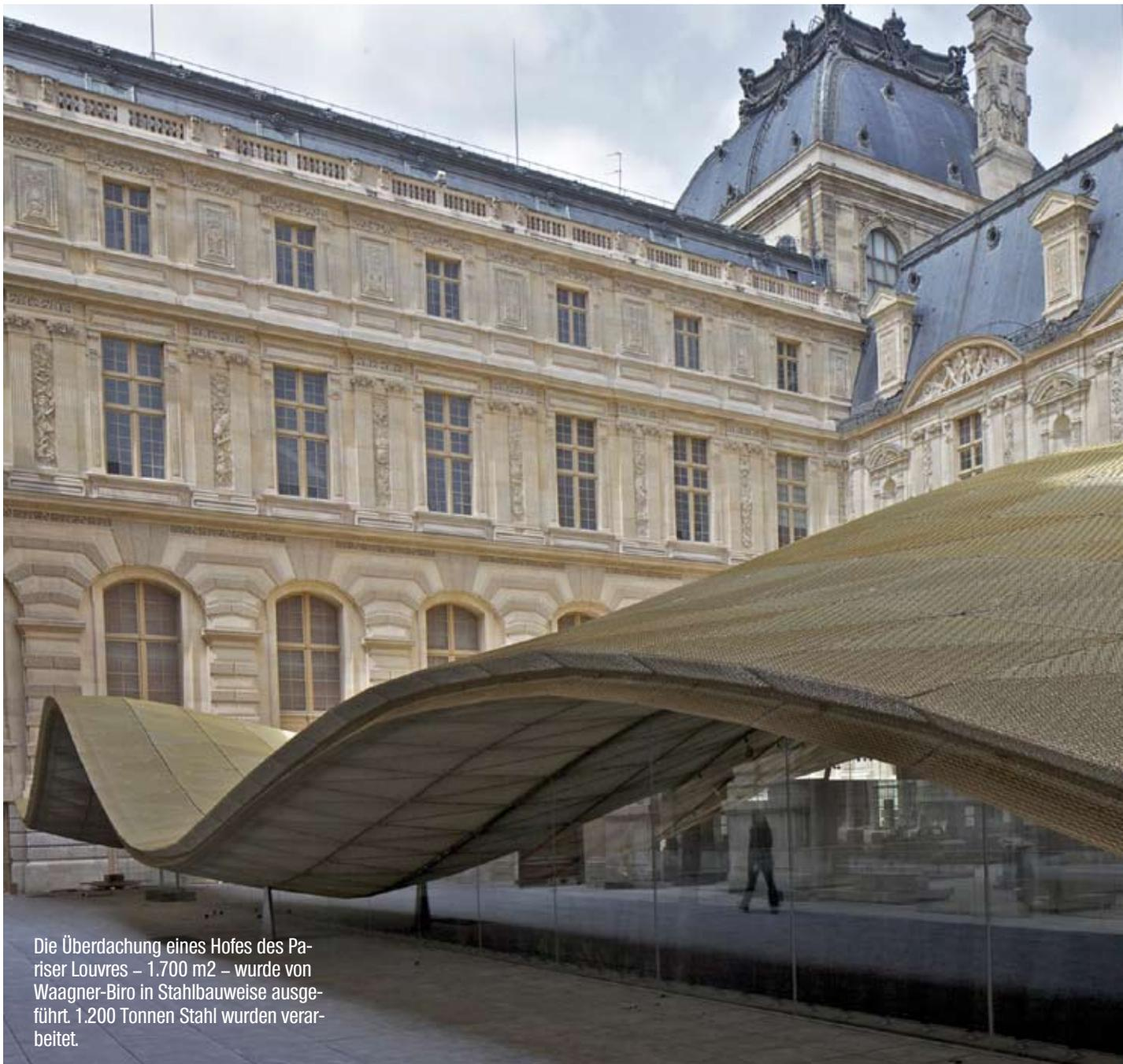
Die Überdachung eines Hofes des Pariser Louvres – 1.700 m<sup>2</sup> – wurde von Waagner-Biro in Stahlbauweise ausgeführt. 1.200 Tonnen Stahl wurden verarbeitet.
