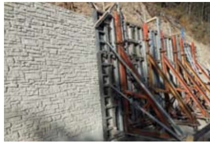
Mit der NOE-Strukturmatrize »Murus Romanus« lässt sich das Erscheinungsbild einer gemauerten Natursteinwand hervorragend widerspiegeln
