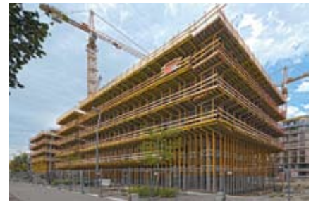
Mit Peri-Lösungen werden architektonisch aufwendige Balkonfassaden am Nordbahnhofgelände in Wien realisiert.
