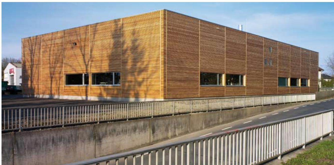
Der Standort der Tischlerei Sternath in Hard wurde 2010 mit der modularen Holzvariante multi-line Holz errichtet.
