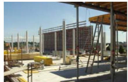
Das neue Innovations- und Forschungszentrum von Backaldrin entsteht mit Ringer-Schalungen.
