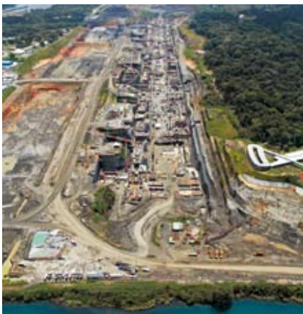
Die Erweiterung des Panamakanals ist der größte Einzelauftrag in der Peri-Geschichte.
