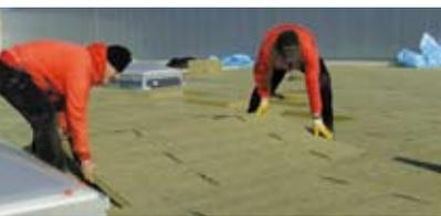
Bewährte Flachdachdämmplatte mit neuer Oberflächenhärte: Die neue »Hardrock 040« von Rockwool zeichnet sich durch eine Punktlast  $\geq 1.000$  N aus.
