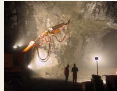
Kaverne im Versuchsstollen Hagerbach.
