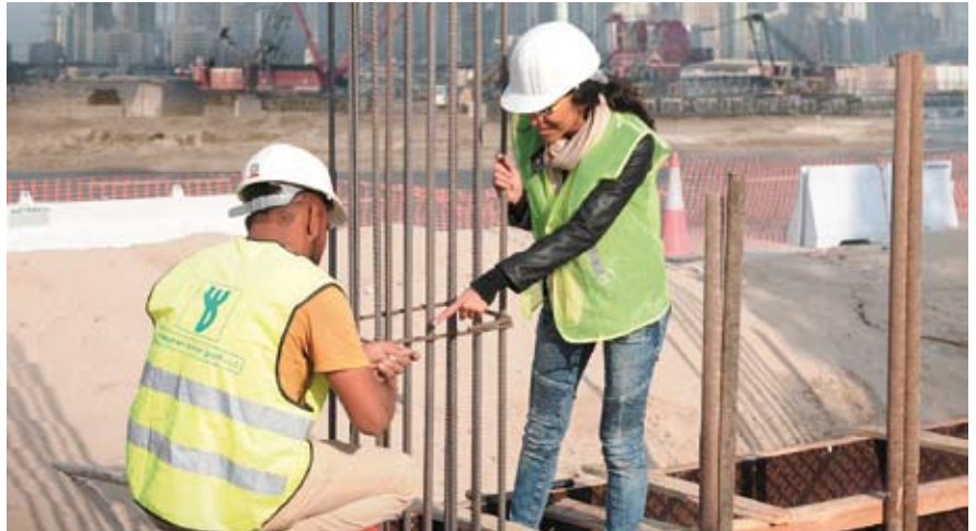
Diversity ist am Bau erfolgsentscheidend. Ein Team mit unterschiedlichen Zugängen erreicht laut Waagner-Biro immer die besseren Lösungen (im Bild: Lilyan Tannous, leitende Ingenieurin bei Waagner-Biro Gulf auf der Baustelle in Dubai).
