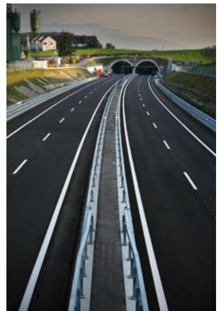
Die sechs Tunnel der Umfahrung Zürich und der Umfahrung Zug verfügen über modernste Gesamtlösungen in Sachen Brandschutz.
