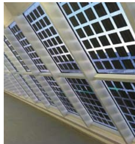
Moderne Architekturlösungen haben in Österreich laut Klima- und Energiefonds einen hohen Stellenwert. Semitransparente PV-Fassaden bilden dabei einen Bereich der GIPV.
