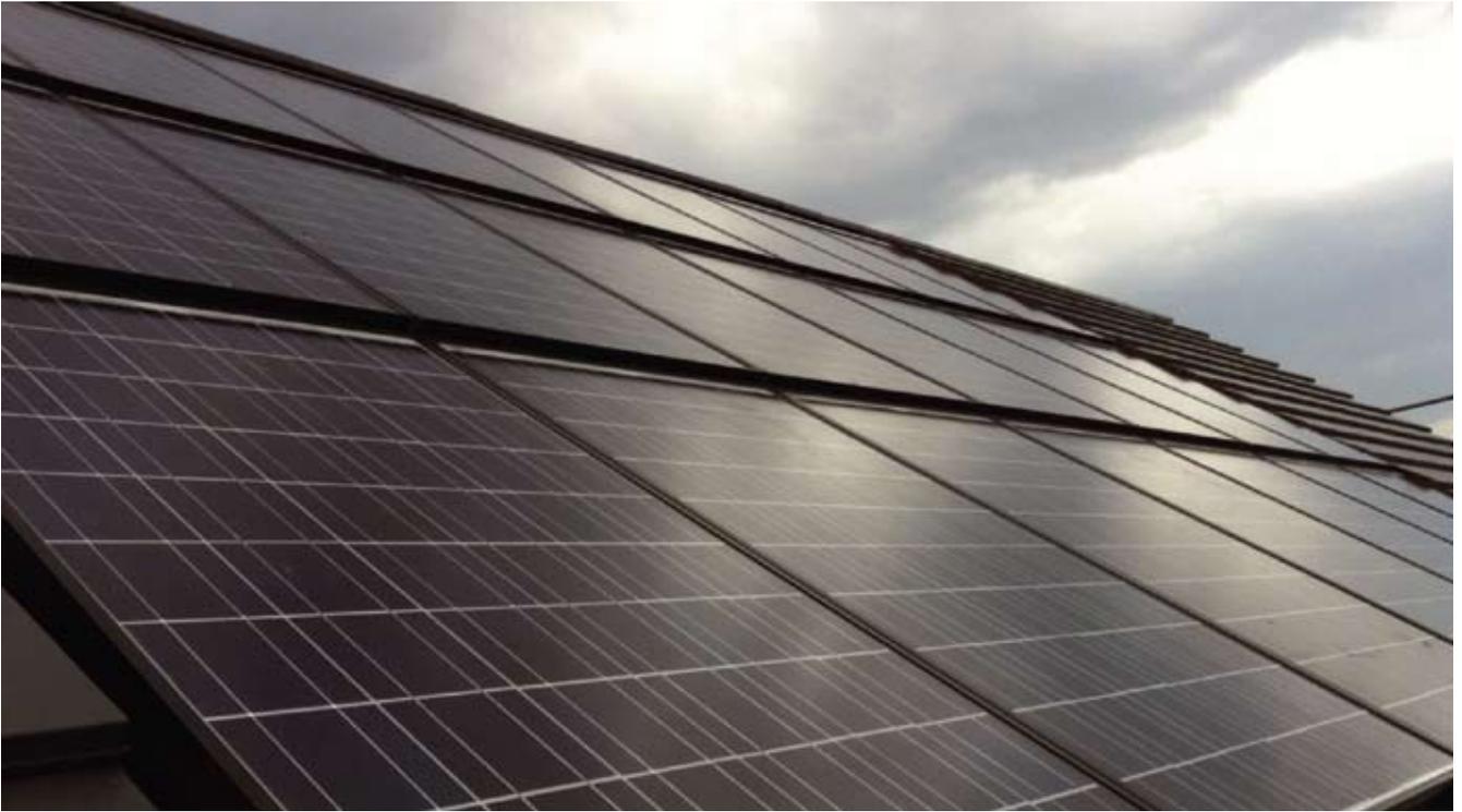
Der Neigungswinkel der Photovoltaikanlage sollte 30 Grad erreichen, um ein Optimum an Leistung zu erbringen. Dann sorgt eine PV-Anlage für eine deutliche Wertsteigerung der Immobilie.
