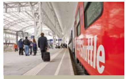
HOCHTIEF integriert in Salzburg denkmalgeschützte, historische Bauteile in modernste Bahninfrastruktur.
