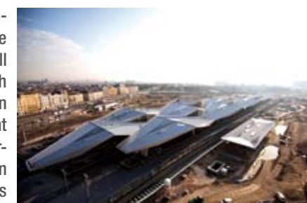
Hauptbahnhof im Zeitplan: Acht der 14 Rautendächer sind fertiggestellt.
