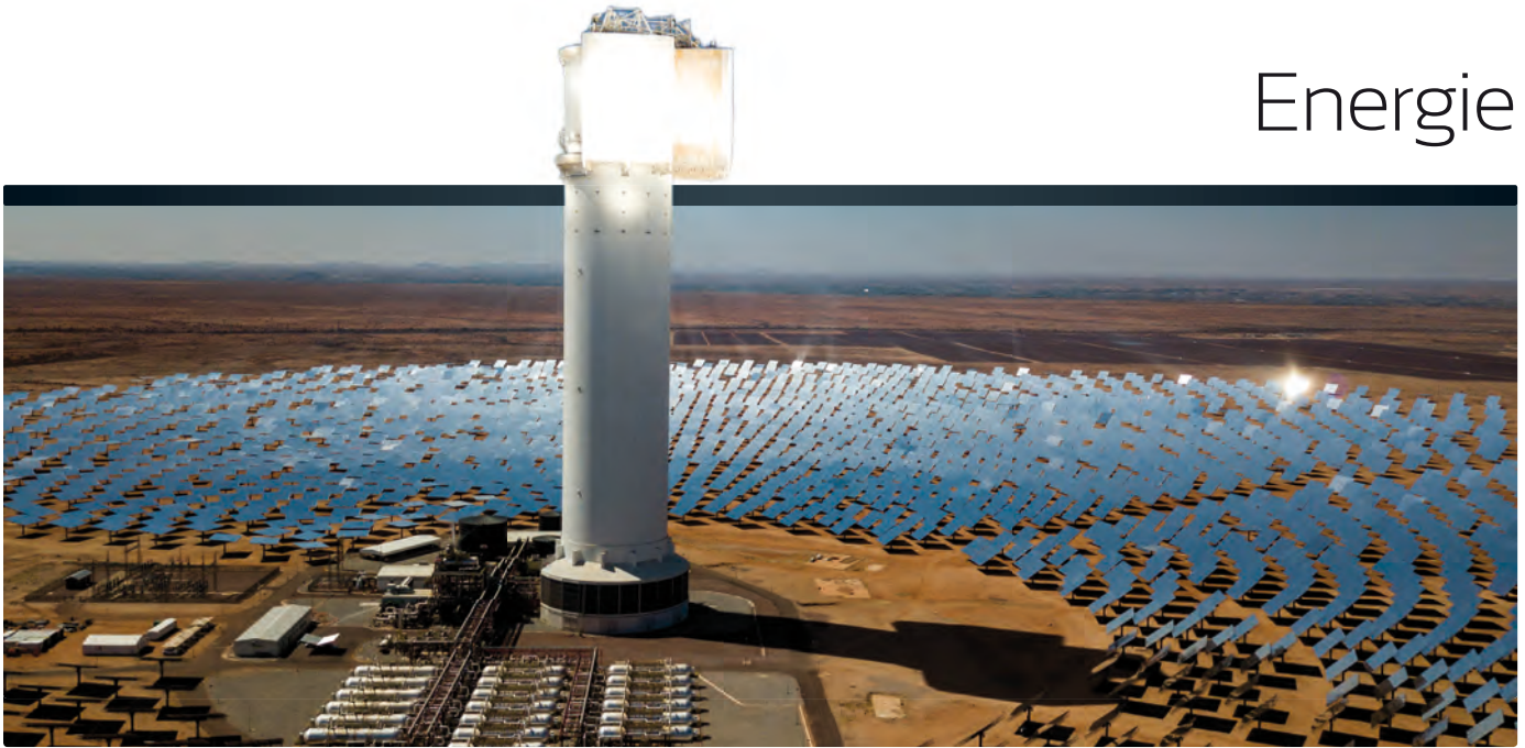
↑ Luftaufnahme von Heliostaten und Turm am Khi Solar One in Südafrika.
