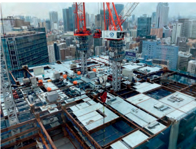
↑ Die erste Station der Japan-Reise war das ehemalige Hamamatsucho-Gebäude, das aktuell durch zwei 235 Meter hohe Türme ersetzt wird.
