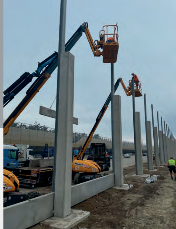
Die Lärmschutzwand bei Biedermansdorf (A 2 Südautohahn) war ein Pilotprojekt.
