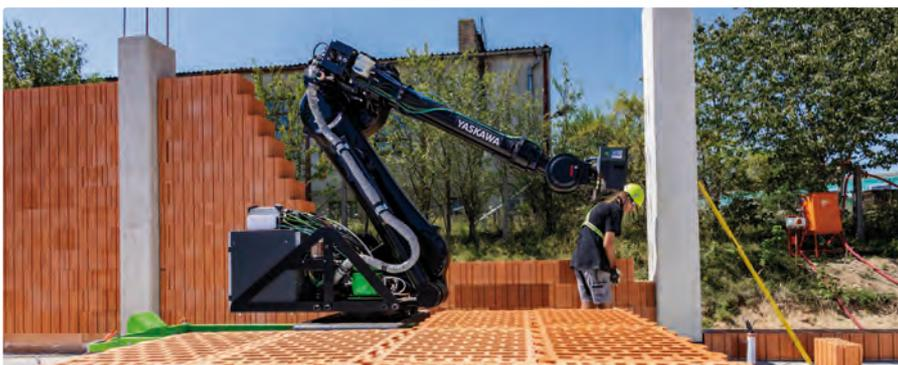
⬆️ Der mobile Bauroboter WLR errichtet Ziegelmauern von über drei Metern Höhe mit einer Leistung von durchschnittlich 5–6 m<sup>2</sup>/Stunde.
