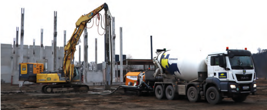
↑ Eine Geräteeinheit für die Herstellung von Betonrüttelsäulen.
