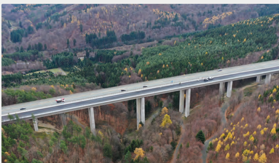
Allianz-Pilotprojekt: Talübergänge S 31 Sieggraben im Burgenland.
