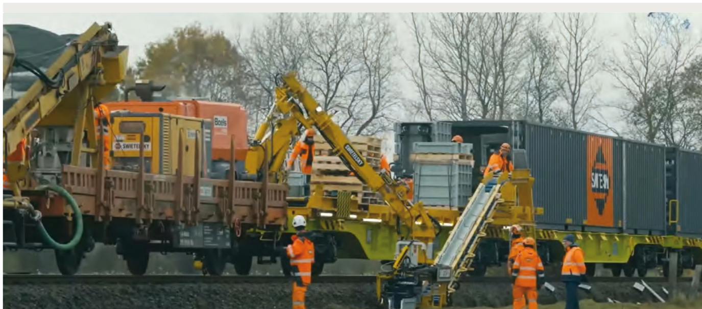
↑ Kabeltiefbau mit einer Flankenprofilierungsmaschine.
