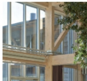
⤴ Aus einer Lagerhalle wurde das LKR Innovation House: Teile der bestehenden Holzfassade und der Dachkonstruktion sowie die Betonbodenplatte blieben erhalten.
