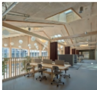
⤴ Aus einer Lagerhalle wurde das LKR Innovation House: Teile der bestehenden Holzfassade und der Dachkonstruktion sowie die Betonbodenplatte blieben erhalten.
