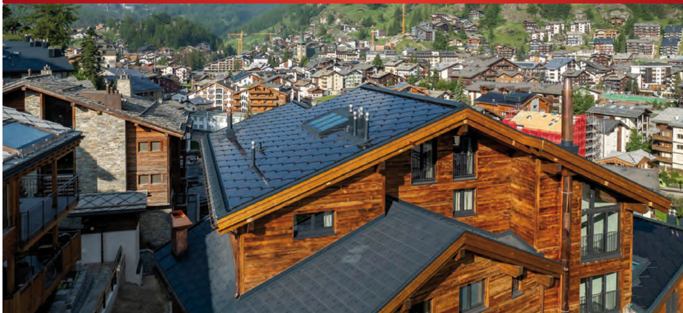
↑ Neues Solardach am Hotel Welschen in Zermatt.
