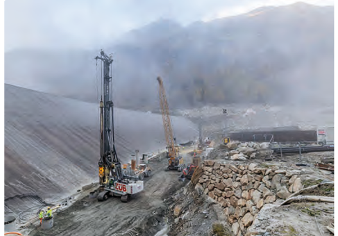
⬆ Liebherr-Geräte erhöhen einen Stausee-Damm in der Kärntner Kraftwerksgruppe Fragant.
