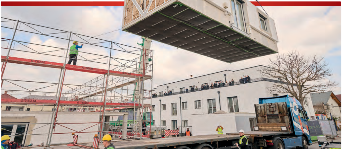
⤴ Modulverhebung auf der Baustelle Wiener Neustadt.
