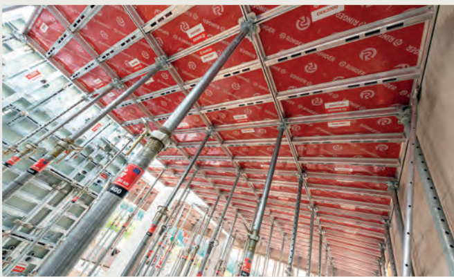
↑ Die Deckenschalung AluDEK ist auf der MAWEV live zu sehen und zu testen.
