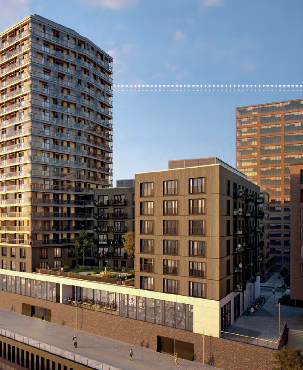
↑ Roots in Hamburg ist mit 65 Metern das höchste Holzhochhaus Deutschlands. Verbaut sind rund 5.500 m 3 Nadelholz.
