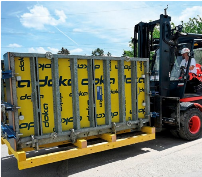
⬆ Mit einer beheizbaren Schalung wird die Aushärtung von CO 2 -reduziertem Beton beschleunigt.
