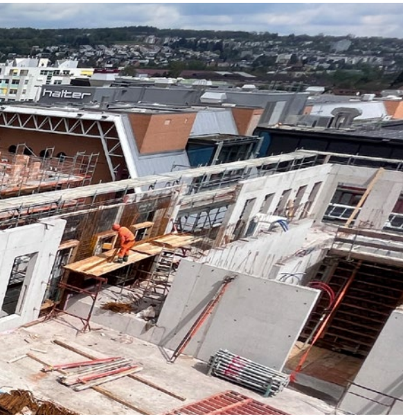
Rhomberg vertraut bei der Errichtung eines fünfgeschößigen Gebäudekomplexes in Zürich bereits auf Zirkulit-Beton und damit auf 75 Prozent Sekundärrohstoffe.
