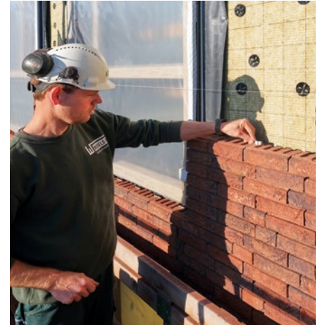
ClickBrick ist das neue Trockenstapelsystem von Wienerberger.
