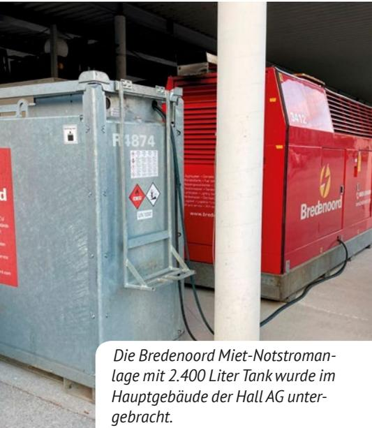
Die Bredenoord Miet-Notstromanlage mit 2.400 Liter Tank wurde im Hauptgebäude der Hall AG untergebracht.
