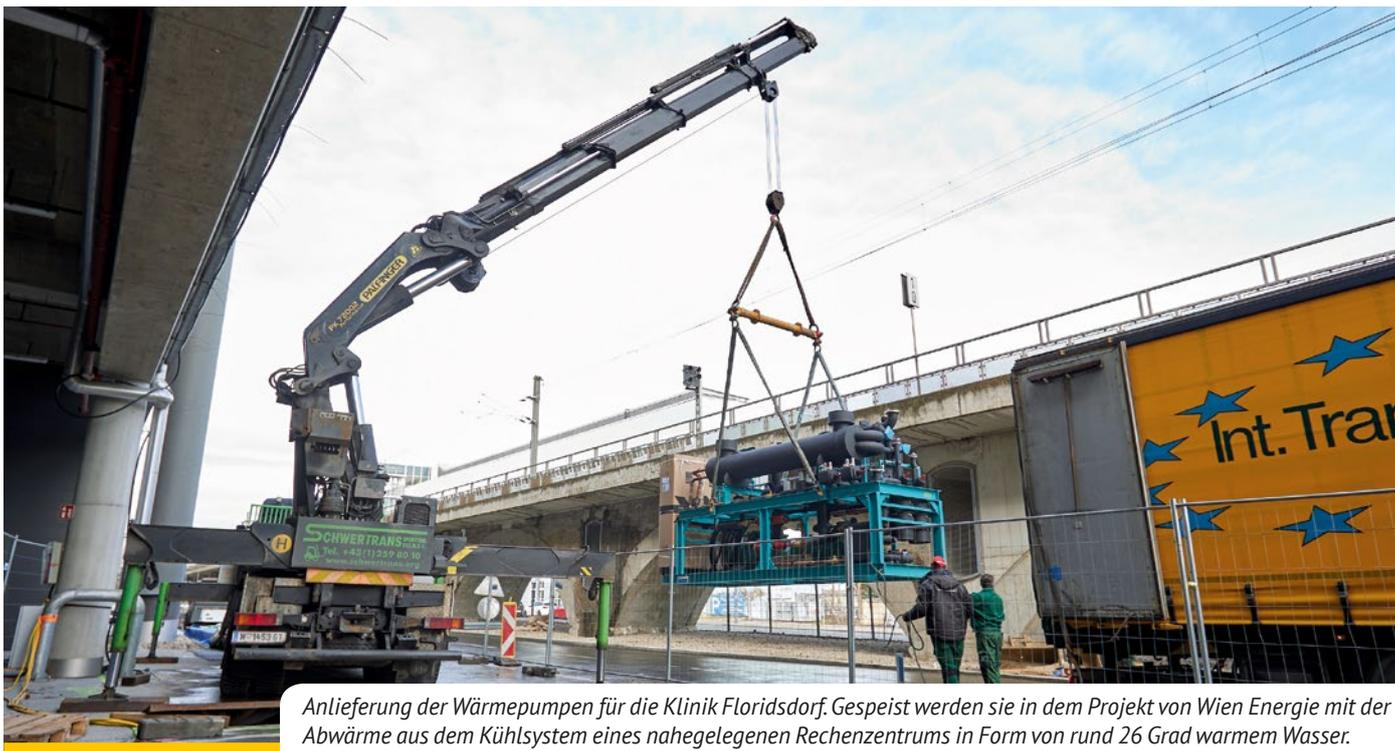
Anlieferung der Wärmepumpen für die Klinik Floridsdorf. Gespeist werden sie in dem Projekt von Wien Energie mit der Abwärme aus dem Kühlsystem eines nahegelegenen Rechenzentrums in Form von rund 26 Grad warmem Wasser.
