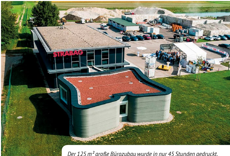
Der 125 m 2 große Bürozubau wurde in nur 45 Stunden gedruckt.
