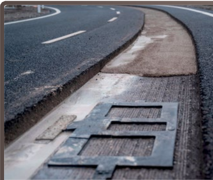
Das Straßenbelagssystem der »Arena del Futuro« enthält u. a. Spezialmörtel für die Induktionsstrahler, eine modifizierte Bitumenbahn und einen speziellen Untergrundmörtel zur Einbettung der Kabel und Steuergeräte.
