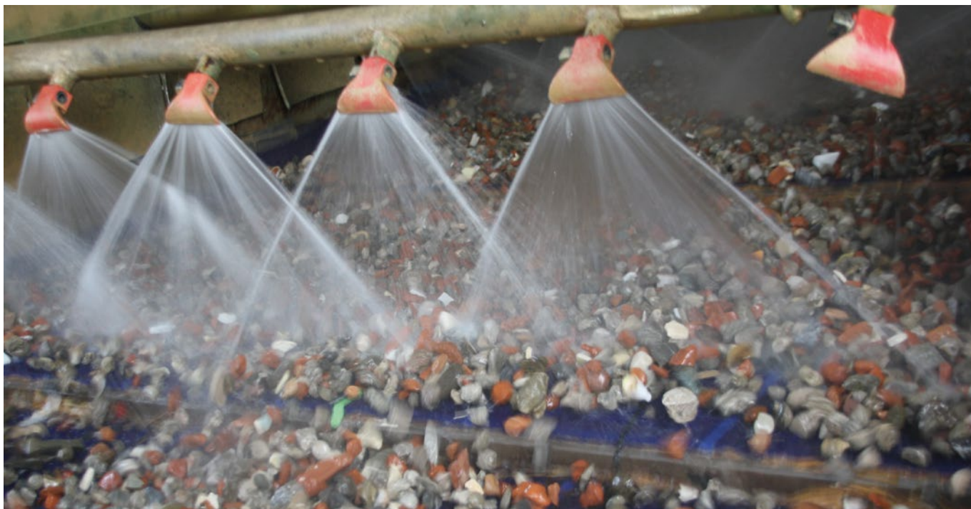
Baurestmassen werden bei Wopfinger händisch von Fremdkörpern wie Plastikteilen befreit und anschließend im Rahmen des Nassaufbereitungsverfahrens gesäubert, wonach Ausgangsmaterial für RC-Beton zur Verfügung steht.
