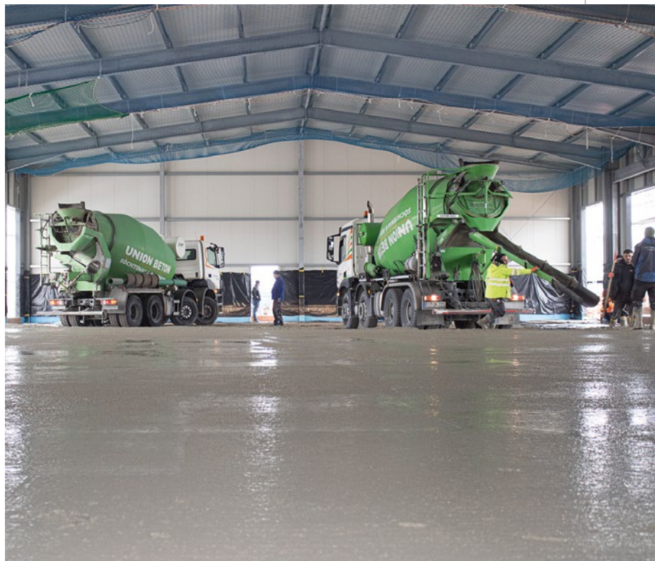
Testbaustelle bei Zosseder: Transportbeton-Mischfahrzeuge von Union Beton bringen den Estrich aus Recycling-Beton aus.
