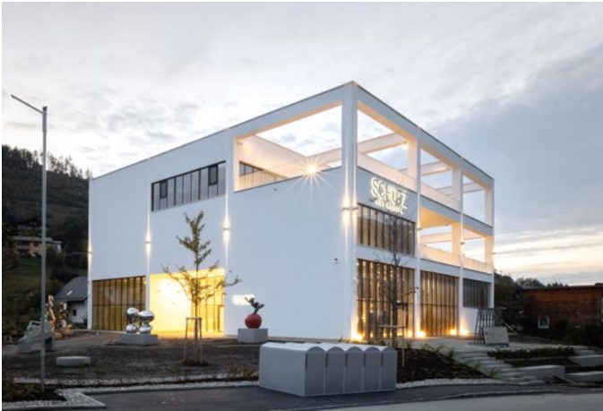
Die Außenwand des SCHÜTZ Art Museum wurde mit einem mineralischen Fassadensystem gedämmt.
