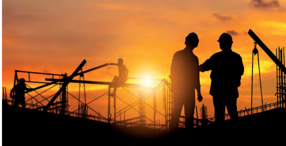
Auch auf Baustellen muss die Ursache von Problemen bekämpft werden, nicht nur die Symptome.
