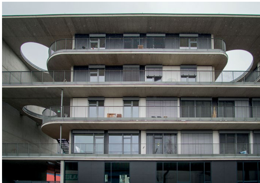
Bei Kiubo werden nicht fertige Module übereinander gestapelt, sondern eine vertikale Struktur errichtet und die Module werden eingeschoben.
