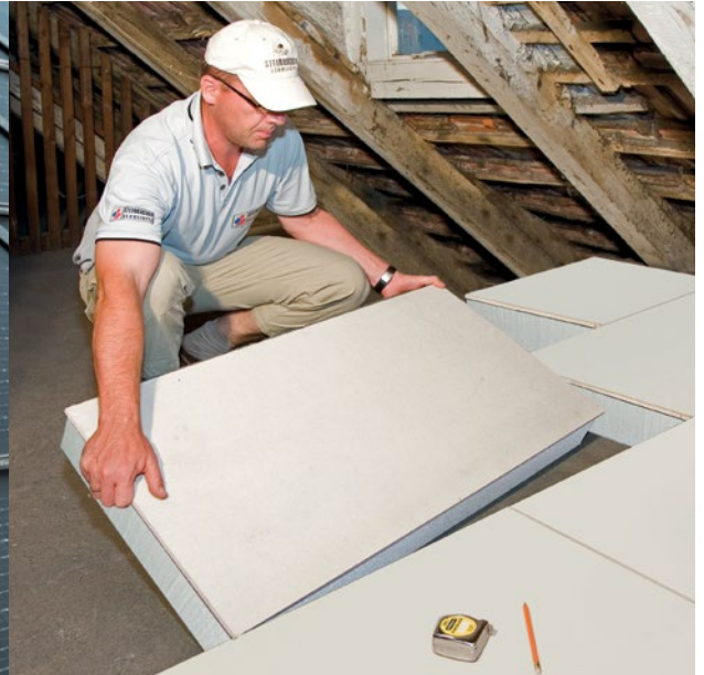
Die Dämmung der obersten Geschoßdecke kann auch von Laien durchgeführt werden.
