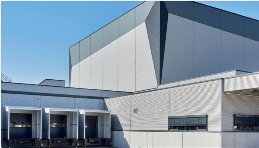
Mit der Variante »Steelrock Plus Ü80« in der Wärmeleitfähigkeit 035 und 240 mm Dämmdicke können wärmedämmende Wandkassetten-Konstruktionen für beheizte Gebäude wirtschaftlich realisiert werden.
