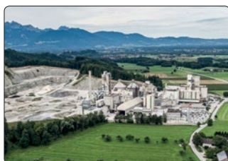
Im Rohrdorfer Zementwerk wird die Pilotanlage zur CO 2 -Abscheidung errichtet.
