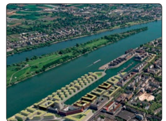
Die UBM hat sich attraktive Baufelder im Mainzer Hafenbecken gesichert.
