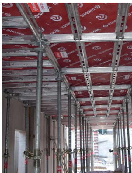
Durch das geringe Gewicht des Deckenschalungssystems AluDEK von Ringer sind die Schalungselemente ideal vom Boden aus zu montieren.
