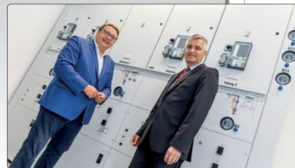
Vorstandsdirektor Martin Graf, Energie Steiermark, und Gerd Pollhammer, Head of Siemens Smart Infrastructure CEE, vor der nachhaltigen Mittelspannungsschaltanlage
