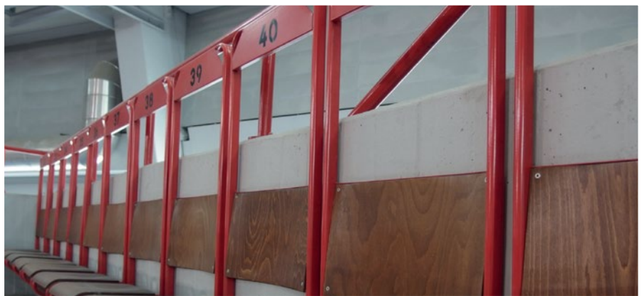
12.000 m 3 Betonabbruch des Ferry-Dusika-Stadions werden von Zöchling vor Ort rezykliert, 1.500 t Metallabfälle über eine eigene Anlage verwertet. BauKarussell verhilft 1.100 Stadionsesseln zu neuem Leben durch Re-Use.
