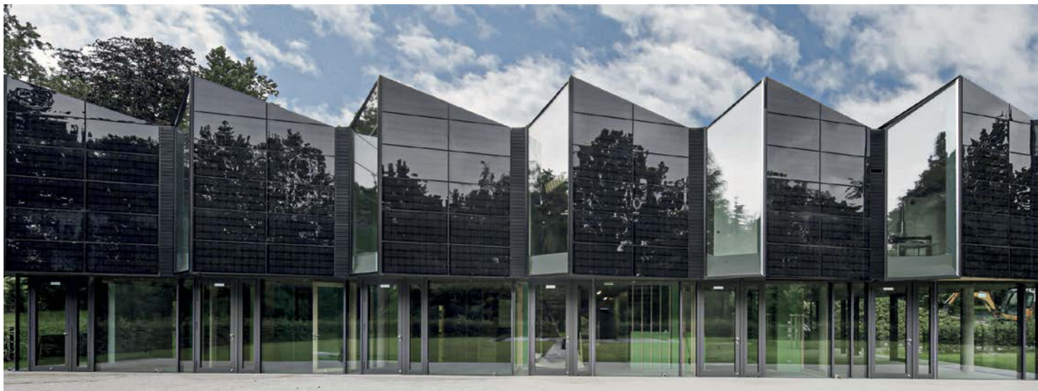
Fassadenintegrierte Photovoltaik nutzt die tieferstehende Sonneneinstrahlung sowie das diffuse Licht und ergänzt damit Aufdachanlagen, die ihre Höchstleistung zu Mittag und im Sommer haben. (Energy Meets Architecture, ertex solar Projekte: oben: +e Kita Marburg, 445 m 2 PV-Fassade, re. oben: Science Center Welios Wels, 60 m 2 PV-Fassade, Mitte: Power Tower Linz, 600 m 2 PV-Fassade, re. unten: Energy Center, Turin, Italien, 190 m 2 PV-Vorhangfassade)
