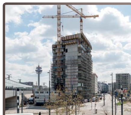
»The Metropolitan« am Wiener Hauptbahnhof wurde von der Strabag als ECI-Projekt abgewickelt – mit einer Kostenersparnis von 5 %.
