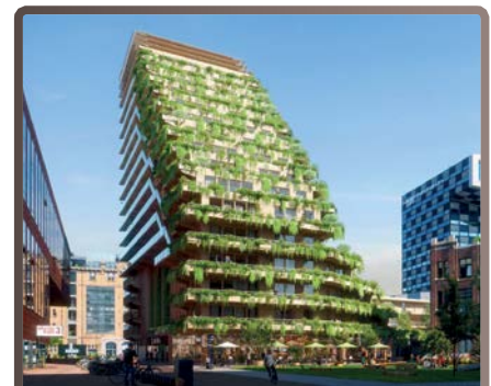
Sawa ist ein 50 Meter hohes, abgetrepptes Wohngebäude aus Brettsperrholz.
