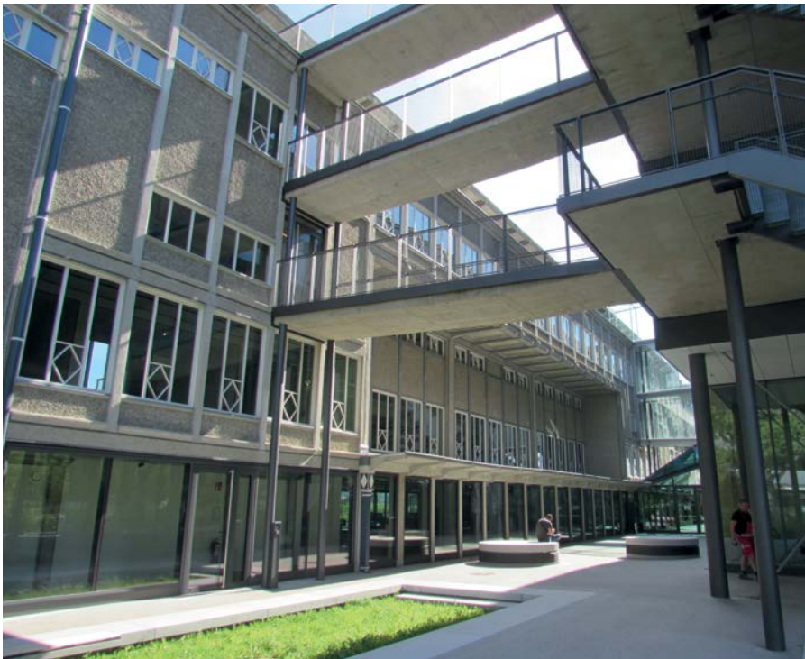
Alte Massivstrukturen in neue Projekte einzubeziehen spart Energie, Ressourcen und Kosten. Ein Ergebnis intelligenter Planung ist die revitalisierte Krieau, Wiens ältestes Stahlbetongebäude.
