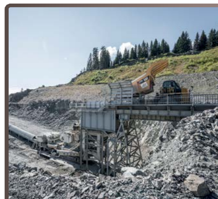
Beim Diabas-Steinbruch erfolgt der Abtransport des Gesteins über ein Förderband.
