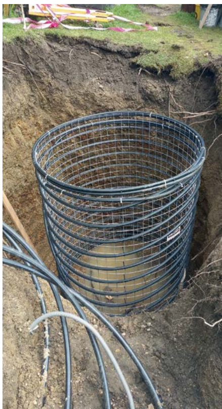
Erdwärmekörbe sind günstiger als Tiefenbohrungen und benötigen weniger Platz als Flächenkollektoren.
