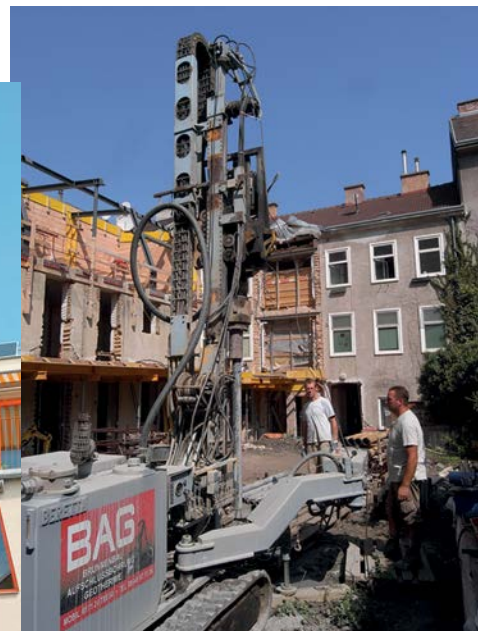
Mit Erdsonden in 110 m Tiefe und Hybrid-Solkollektoren werden beim Projekt Smart Block Geblergasse in Wien bereits zwei Gebäude klimaneutral mit Wärme bzw. Kälte versorgt.
