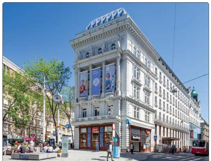
Die Fassadenrenovierung des ehemaligen Hotel Kummer erfolgte mit Produkten aus der Histolith-Reihe für den Denkmalschutz.
