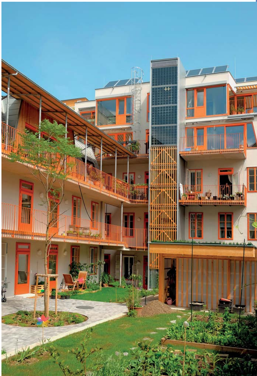
Mit Erdsonden in 110 m Tiefe und Hybrid-Solkollektoren werden beim Projekt Smart Block Geblergasse in Wien bereits zwei Gebäude klimaneutral mit Wärme bzw. Kälte versorgt.
