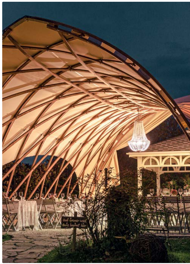
Der STROHBÖID Pavillon ist 70 m 2 groß, besteht aus einer Holzgitterschale und einem Membrandach.
