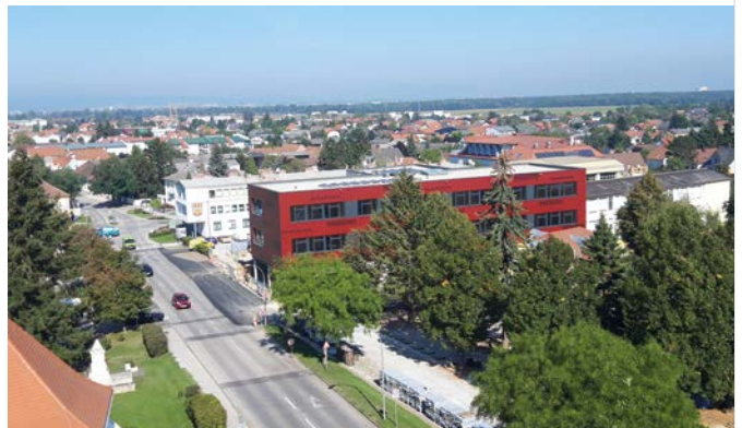
Wie die Umsetzung von Energiegemeinschaften funktionieren kann, wird derzeit im Rahmen des Leitprojekts »RES 2 Community« erforscht.
