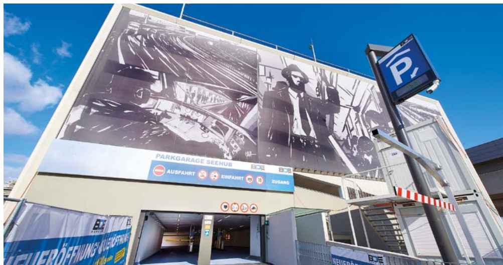
In der Hochgarage SeeHub testet Aspern Smart City Research (ASCR) eine intelligente, umweltfreundliche Ladeinfrastruktur.
