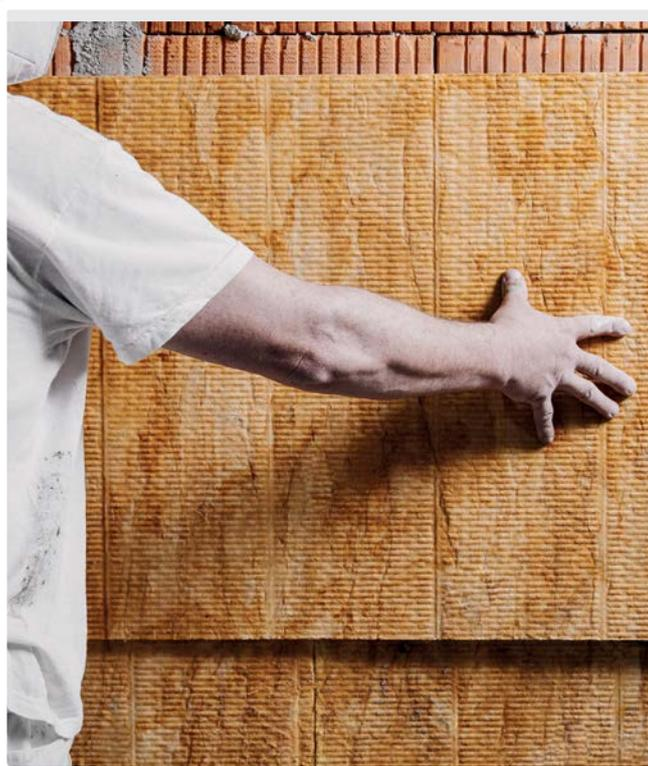
Das neue System von Weber ist nicht brennbar und kann in allen Gebäudeklassen eingesetzt werden.
