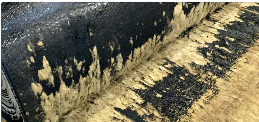
Schon während des Schweißvorganges kann durch Zurückrollen der Bahn die Haftung zur Dämmstoffoberfläche optisch kontrolliert werden. Zeigt sich die Unterseite nahezu flächig mit Steinwolleflocken bedeckt, so ist der optimale Haftverbund erreicht.
