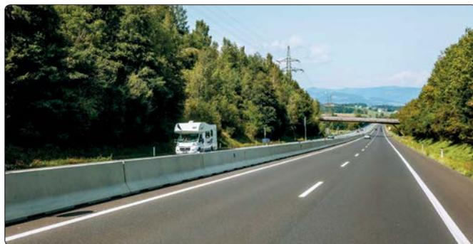
Leitwandensysteme aus Betonfertigteilen punkten bei Eigenschaften wie Errichtungsgeschwindigkeit, Erhaltung, Wiederverwendung, Lebensdauer, Recyclingfähigkeit und Verfügbarkeit.
