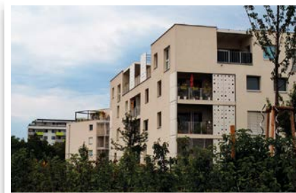
In der Mühlgrundgasse im 22. Bezirk entstand Wiens erster sozialer Wohnbau mit thermischer Bauteilaktivierung. Betonwände und -decken sorgen für ideale Temperaturen.
