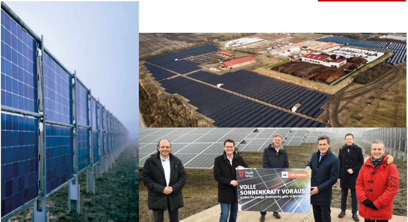
Die neue Photovoltaik-Anlage in Wien-Donaustadt, Anfang April von Stadt Wien und Wien Energie eröffnet, deckt den Bedarf von rund 4.900 Haushalten. Ein Teil des Areals dient zudem von April bis Oktober als Weidefläche für Schafe.
