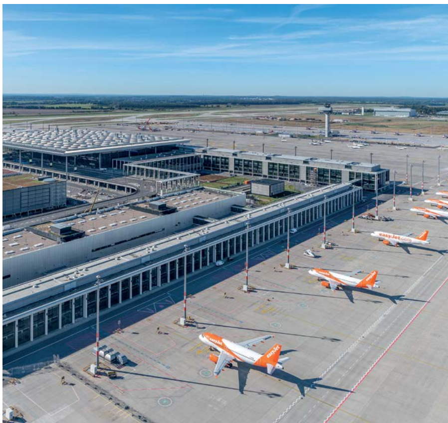
Anders als das Hauptgebäude wurde Terminal 2 des Flughafens Berlin Brandenburg dank BIM in Rekordzeit konzipiert und realisiert.
