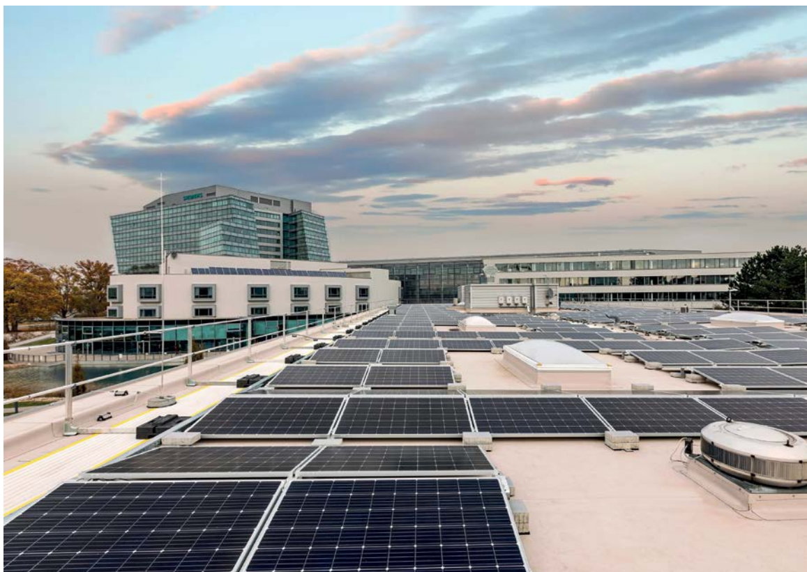
Die in das Microgrid eingebundenen PV-Anlagen decken bis zu 8 % der Anschlussleistung des Standortes in Wien.
