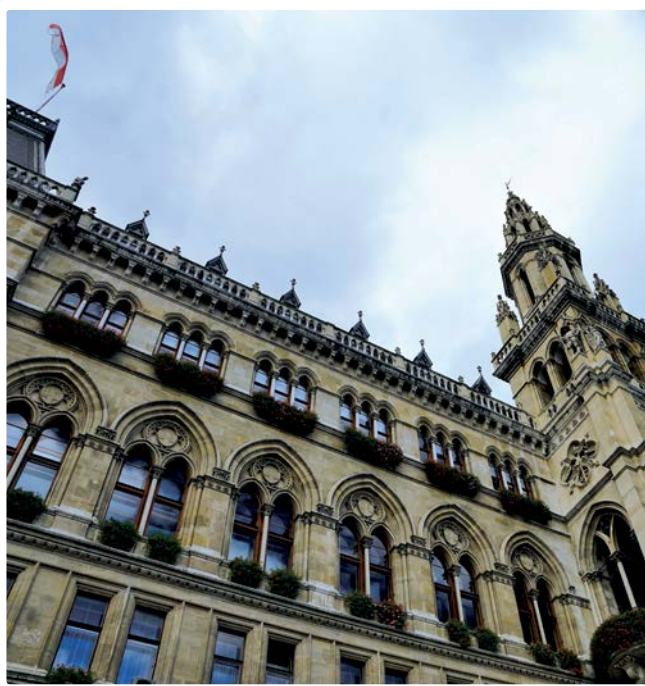
In Wien können Bauverfahren jetzt von der Einreichung bis zur Fertigstellung digital abgewickelt werden.
