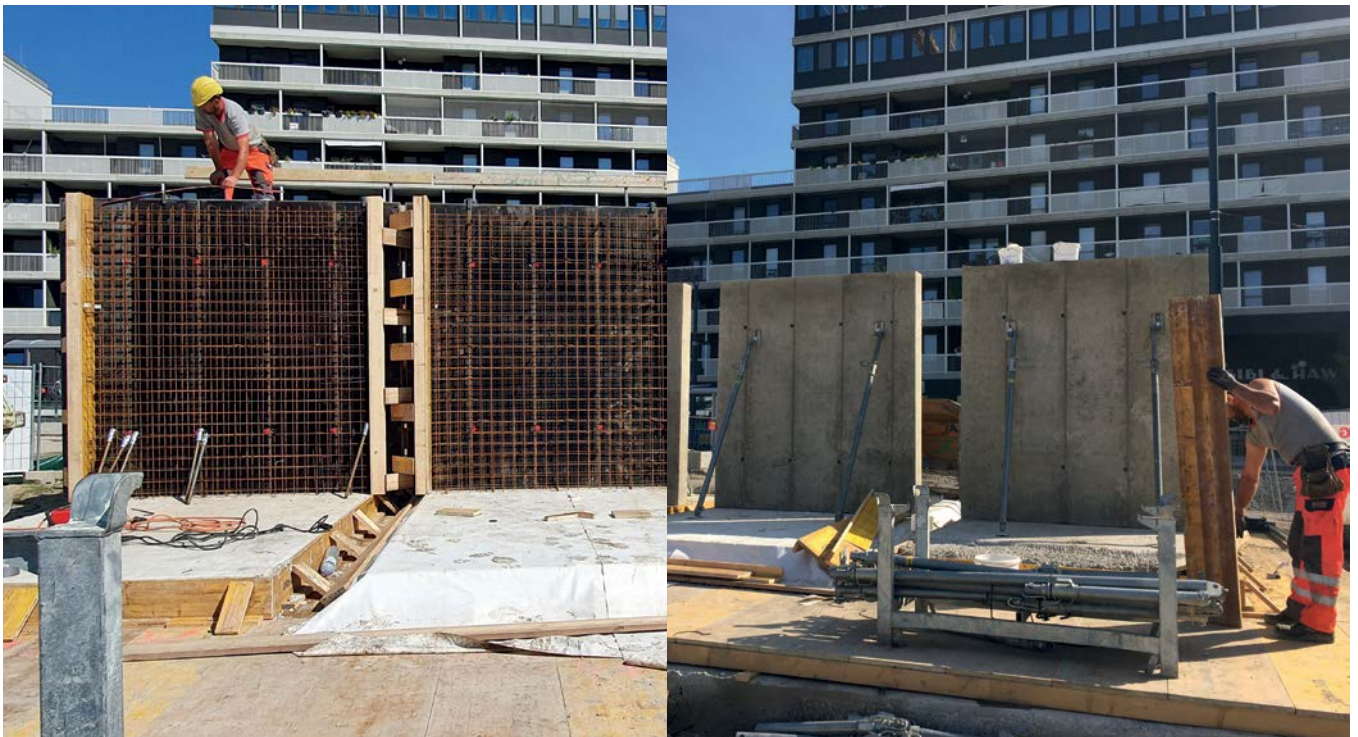
Links der Versuchsaufbau für die Wände sowie bereits betonierte Deckenelemente mit unterschiedlicher Nachbehandlung. Rechts die Wände nach der Entschalung.
