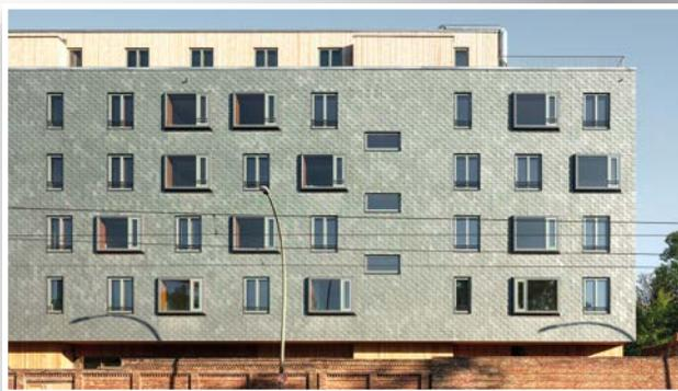
die positiven Eigenschaften des Holzes erlebbar zu machen, das Bauen mit Holz zu vereinfachen und Kosten zu reduzieren. Der Rohbau wurde aufgrund der werksseitigen Vorfertigung in nur 31 Wochen errichtet.
