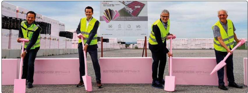
Horst Ache (Unger Stahlbau GmbH), Heimo Pascher (Technischer Geschäftsführer Austrotherm GmbH), Klaus Haberfellner (Geschäftsführer Austrotherm Gruppe) und Johann Moser (Vize-Bürgermeister Stadtgemeinde Purbach) beim Spatenstich.
