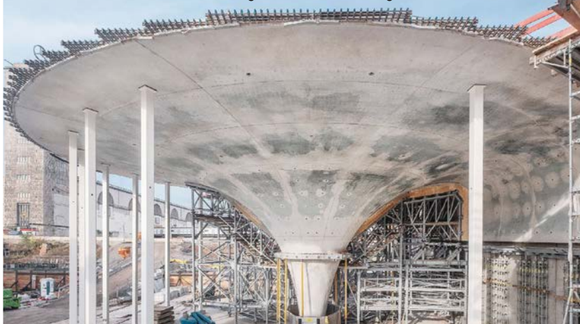
Betonierte Kelchstütze für die Bahnsteighalle des neuen Stuttgarter Tiefbahnhofs.
