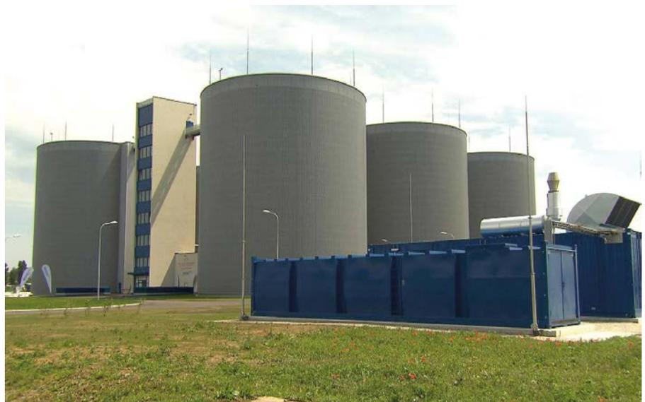
Die sechs Faulbehälter mit einem Gesamtvolumen von 75.000 Kubikmetern sind das sichtbarste Zeichen der neuen Anlage.
