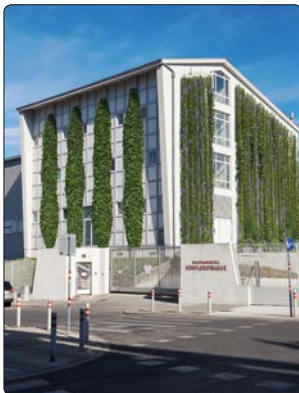
Facilitycomfort lässt das Umspannwerk Kendlerstraße in Grün erstrahlen.
