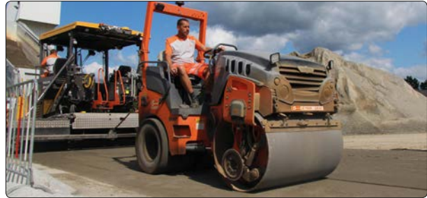
Feldversuch für den Einsatz von Walzbeton im Straßenbau bei Leyrer + Graf.
