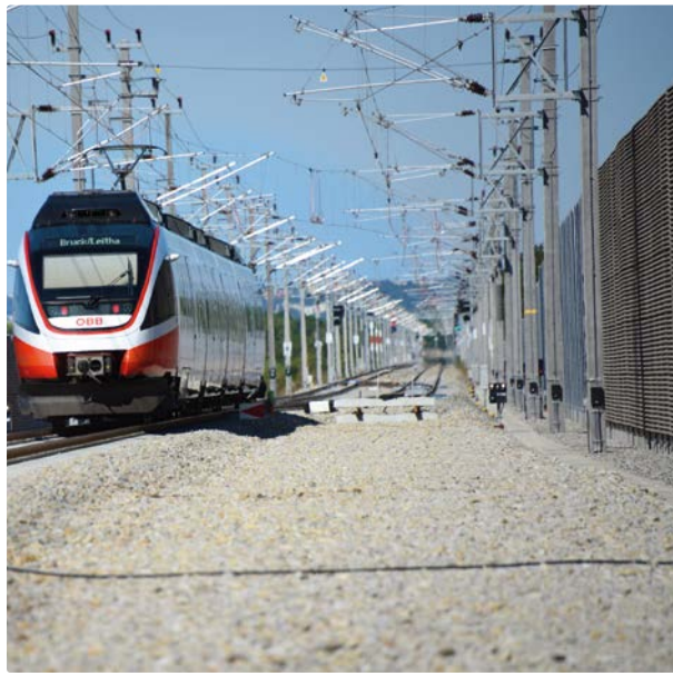
MABA-Lärmschutzverbauung entlang des neu errichteten Bahnhofs Münchendorf im Zuge des zweigleisigen Ausbaus der Pottendorfer Linie in Niederösterreich.
