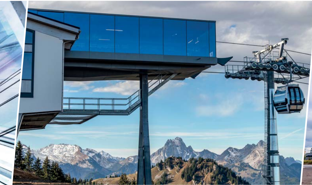
Für den Kubus einer Schweizer Seilbahn mit Wellblechdach und Glasfassade entwickelte das Vorarlberger Unternehmen Glas Marte ein besonderes Befestigungssystem.
