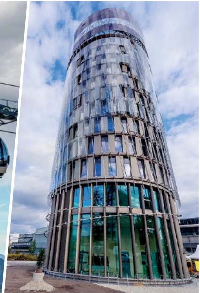
Die äußere Hülle des Science Tower in Graz besteht aus Dünnglasplatten.
