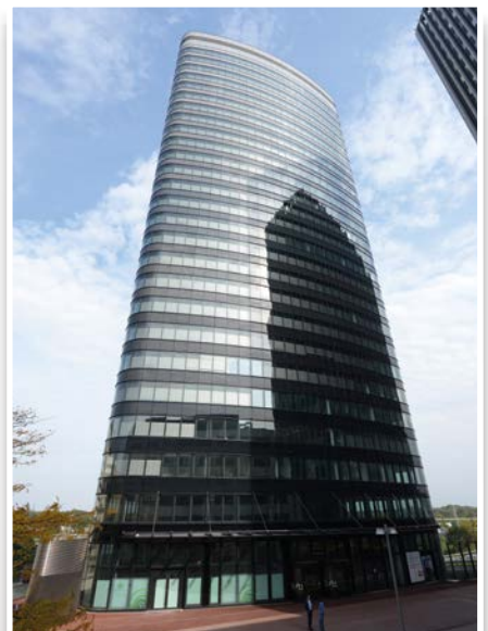
Fotos: Apleona, Facility Comfort
